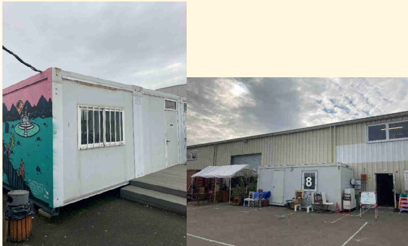
Constructions modulaires dans les chantiers Prélude (Rennes) et Emmaüs Mundo (Strasbourg)
